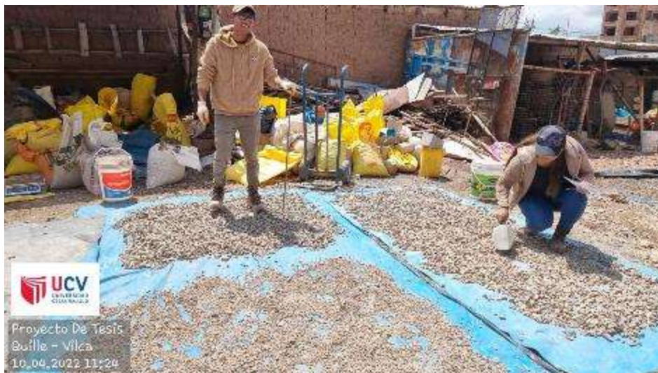
Secado de agregado grueso
