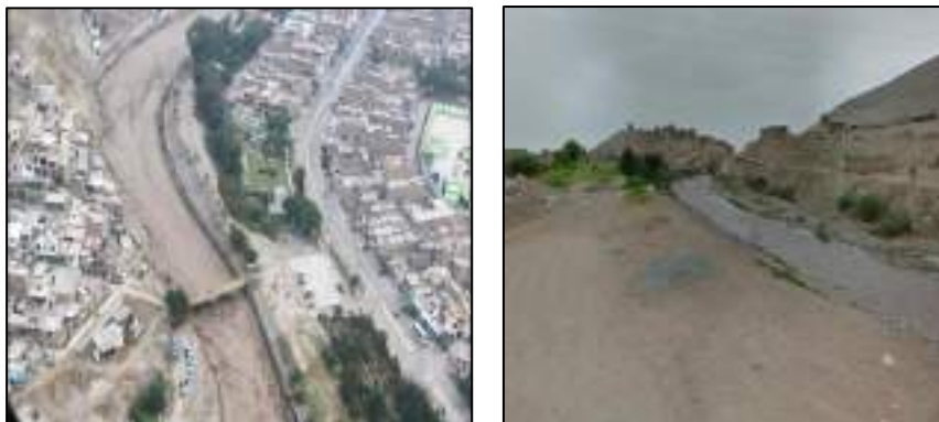
IMAGEN 32: ESTADO DEL RIO CHILLON
