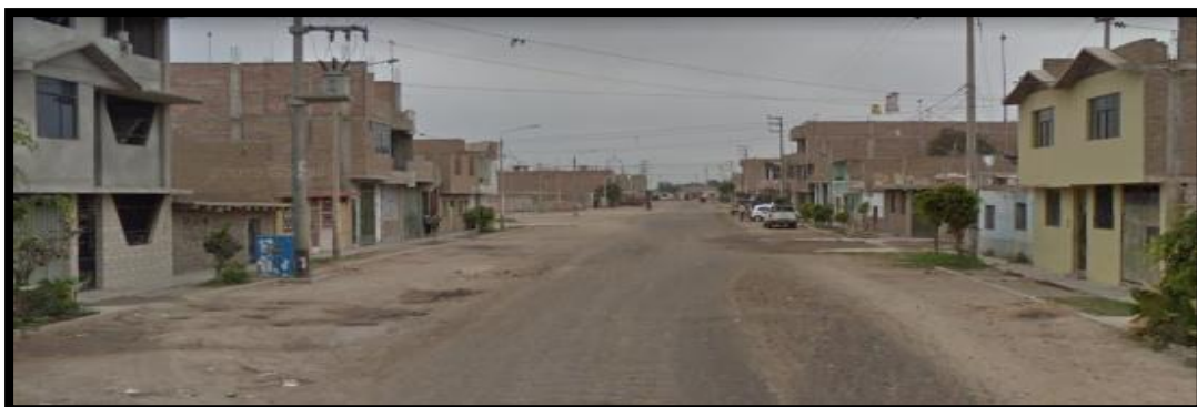
Figura 5: Calle 25 Fuente: Elaboración Propia.
