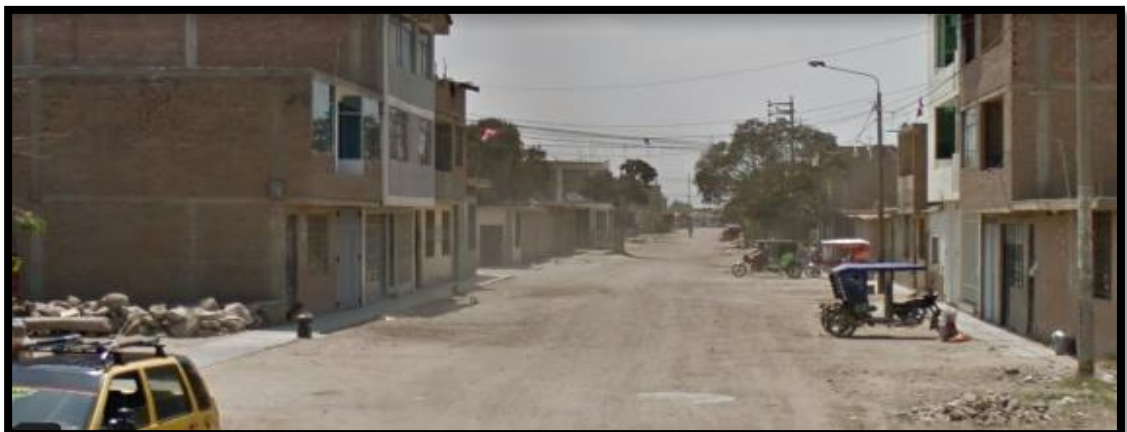
Figura 4: Calle 13 Fuente: Elaboración Propia.
