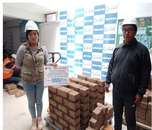
IMAGEN 20: Armado de muretes.
