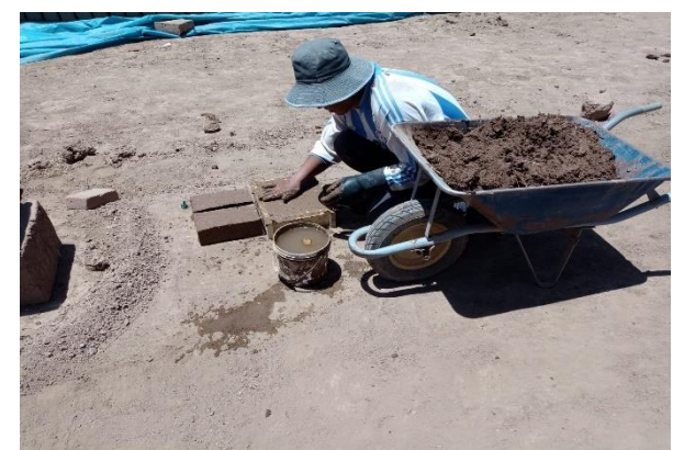
IMAGEN 16: Elaboración de bloques de adobe.
