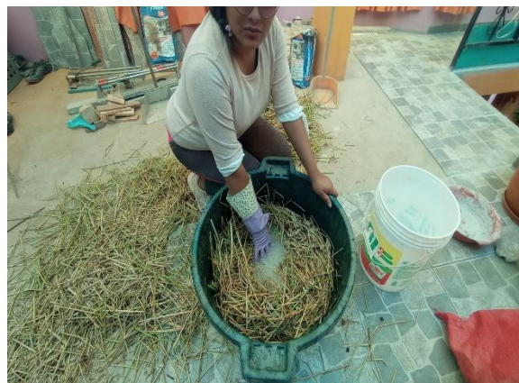
IMAGEN 6: Puesta de totora en agua con cal, para separar cualquier tipo de organismo vivo.
