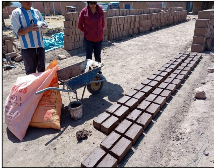
Figura 29. correcto colocado de adobes para su secado respectivo
