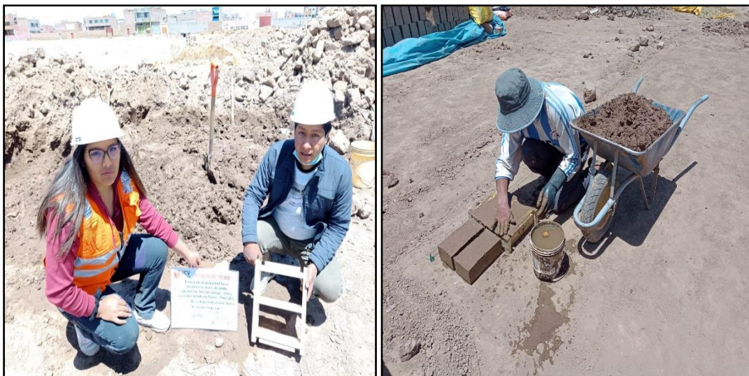
Figura 28. Elaboración de bloques de adobe
