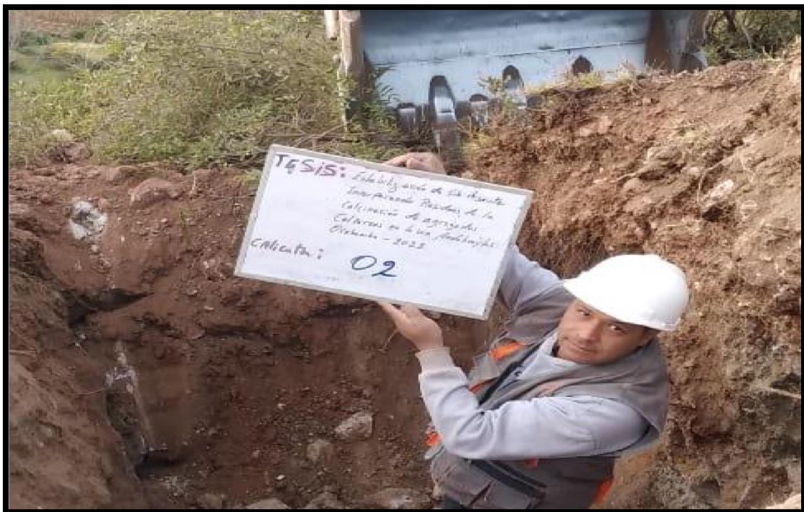
Figura 20. Excavación de Calicata C - 2.
