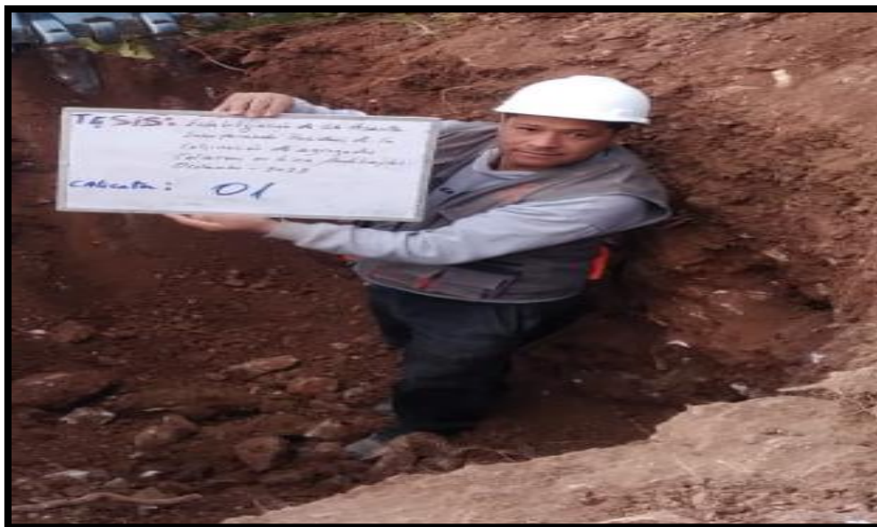
Figura 7. Excavación de C-1
