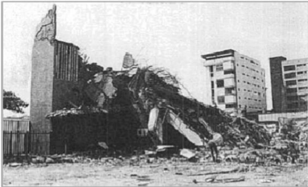
Figura 6 Edificio Miramar, después del terremoto de 1997
