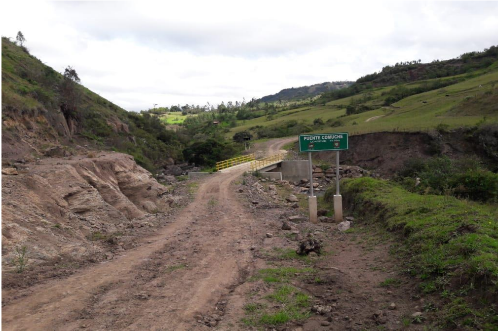
FOTO N° 3. Se observa puente Comuche en buenas condiciones
