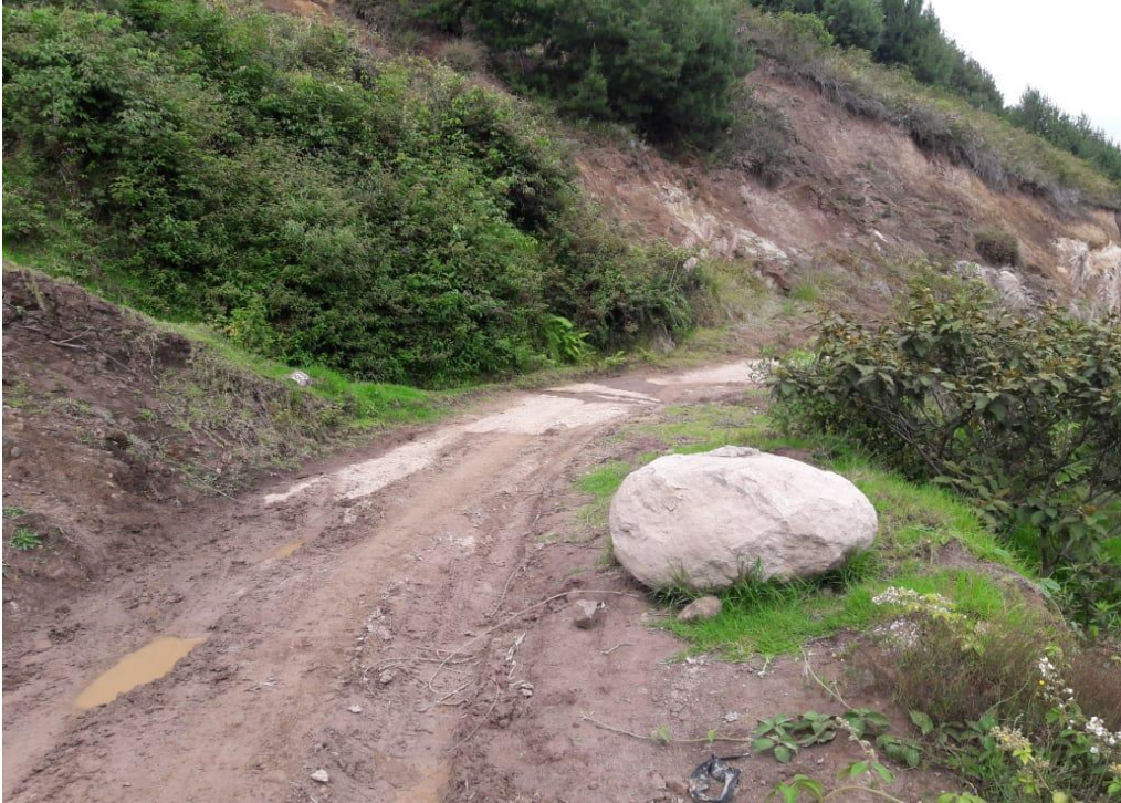
3. Se muestra la vía con presencia de aniegos y no se presentan cunetas para su evacuación pluvial
