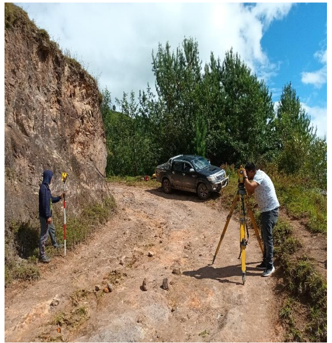
Figura 5-6. Levantamiento topográfico de viviendas existentes. Fuente: Elaboración propia.
