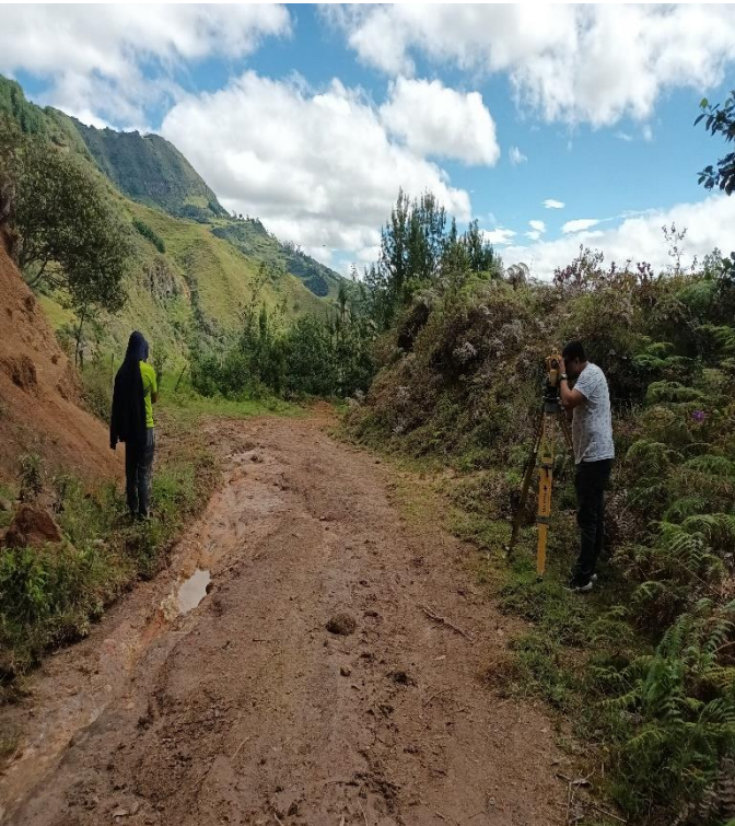
Figura 11-12. Toma de puntos en Secciones de vía existente. Fuente: Elaboración propia.
