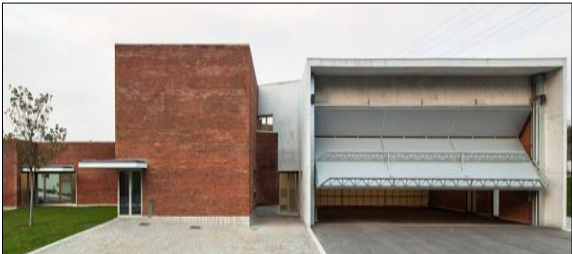
Estación de Bomberos de Santo Tirso
