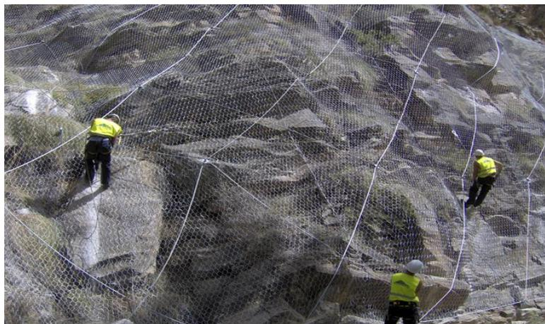
*Figura 43: Malla reforzada con cables*
