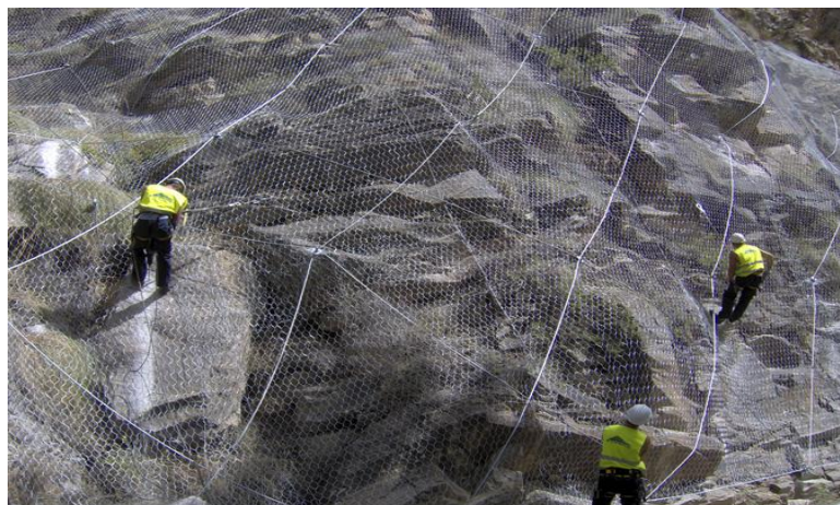
Figura 43: Malla reforzada con cables
