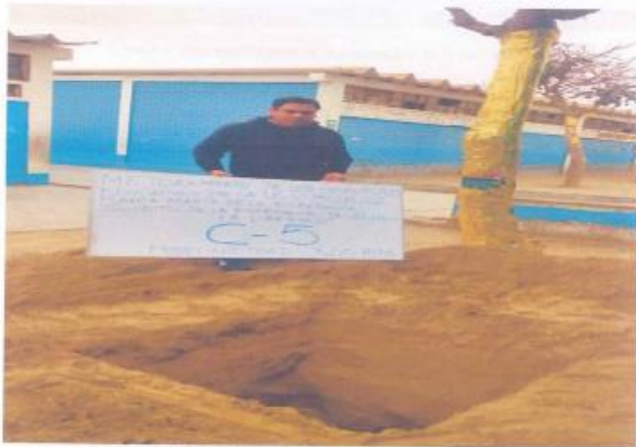
Fotos 12: Vista Panorámica de la Excavación de la calicata C-05, con un primer estrato superficial de 0.30 mts de suelo contaminado con material de relleno y orgánico, un segundo estrato de 2.70 mts de suelo de arena fina, de color beige
