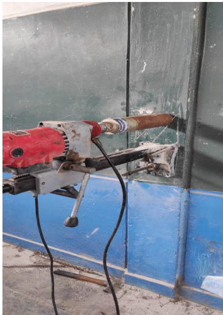
Figura 9. Extracción en el módulo H.
