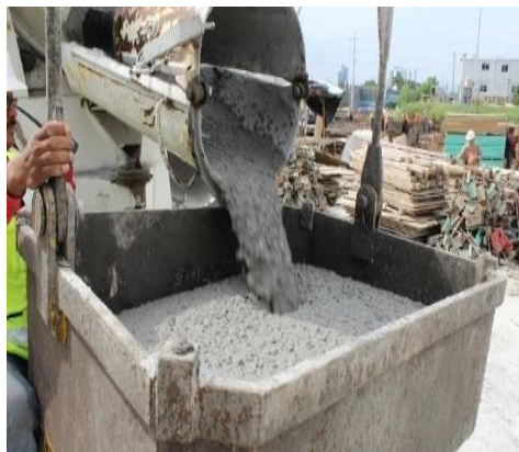
Figura 2 El concretó en obra
