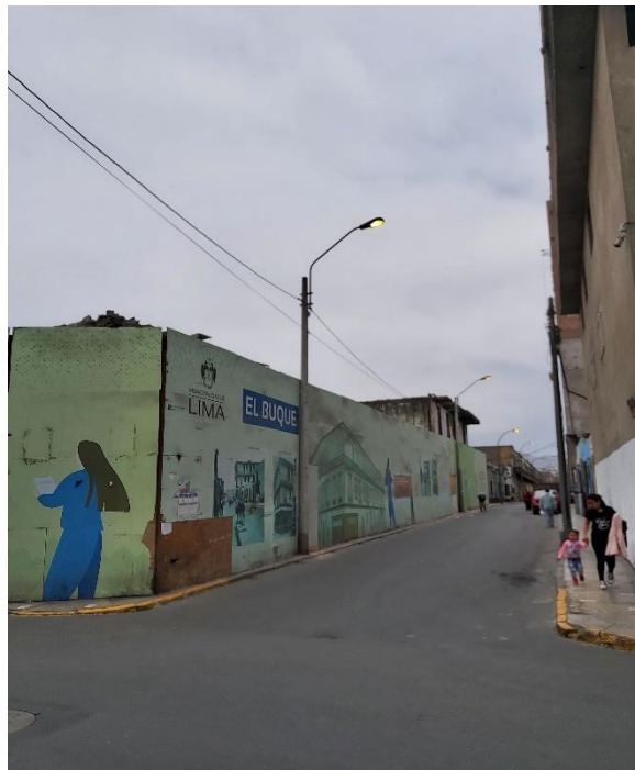
Fuente: Elaboración propia (2022) Casona “El Buque”, pérdida total del inmueble
