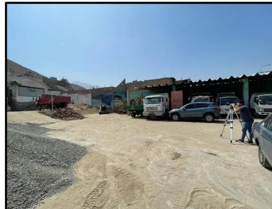
Verificación de niveles y replanteo
