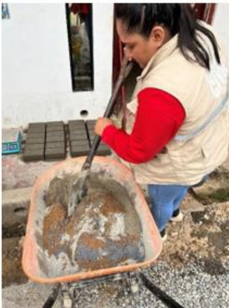
Dosificación de mezcla para el concreto patrón y el concreto con los diseños establecidos, utilizando, arena fina, arena triturada, cemento y agua.
