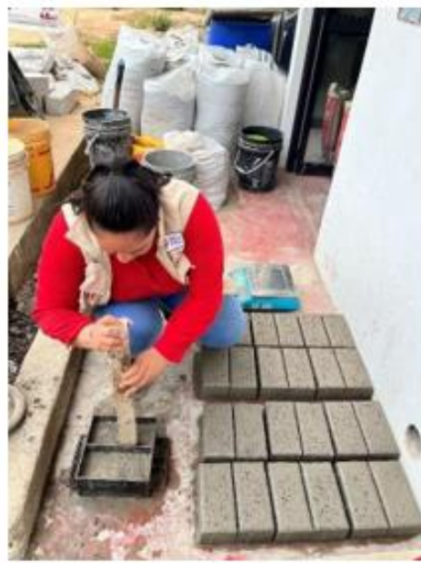
Elaboración de las unidades de adoquines con la utilización de molde artesanal de las medidas 8 cm de ancho, 10 cm de alto y 20 cm de largo.
