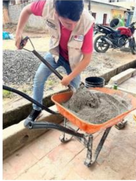
Combinación de material arena fina y arena natural haciendo uso de las herramientas de una palana y carretilla
