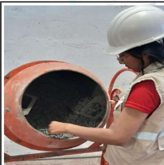
Fotos n° 09-10: En las imágenes podemos observar al personal realizando el control de la temperatura del diseño.
