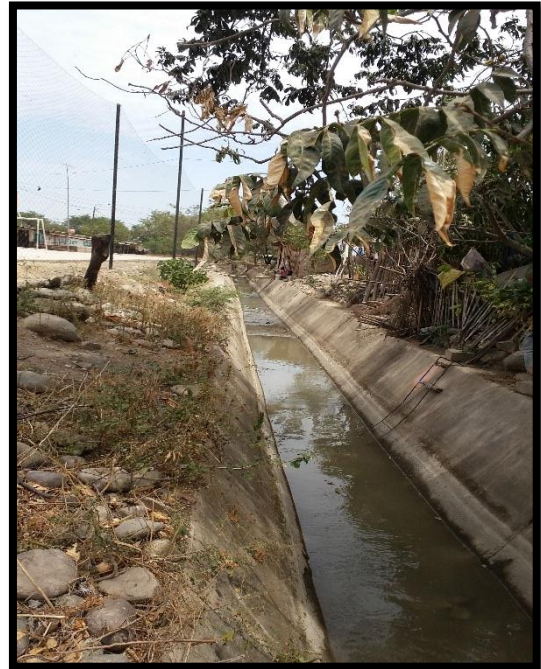
Figura 10: Vista panorámica del canal
