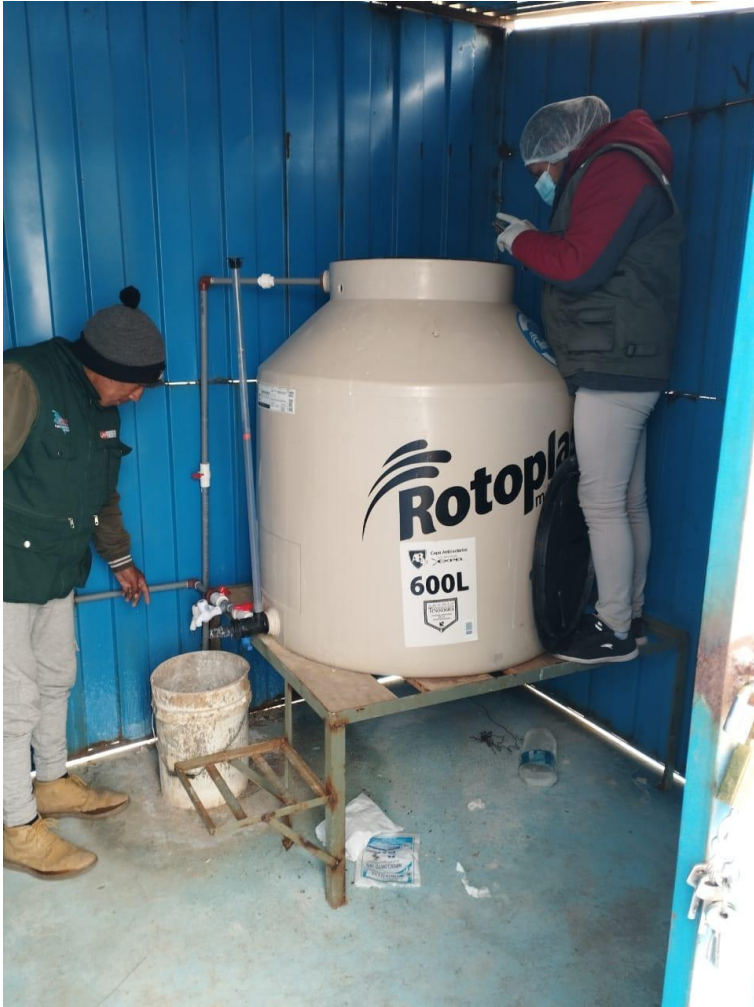
Fotografía 3. Recarga de cloro en el sistema de agua del distrito de Potoni.
