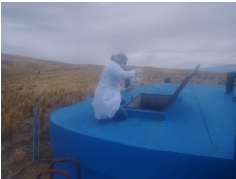
Fotografía 1. Toma de detalla del reservorio del sistema de distrito de Potoni
