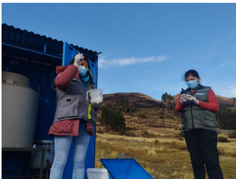
Fotografía 5. Recarga de cloro en el sistema de agua del distrito de San Antón.
