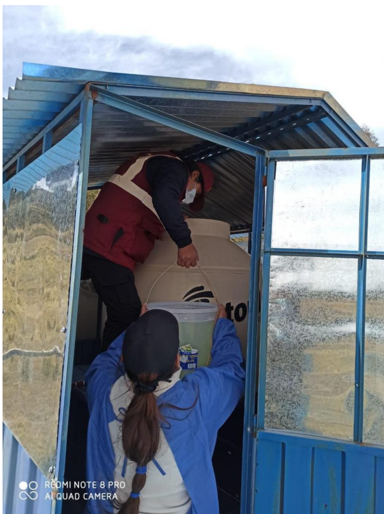
Fotografía 5. Recarga de cloro en el sistema de agua del distrito de San Antón.
