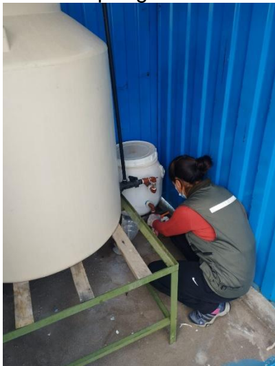
Figura 20. Calibración del sistema de cloración pro goteo
