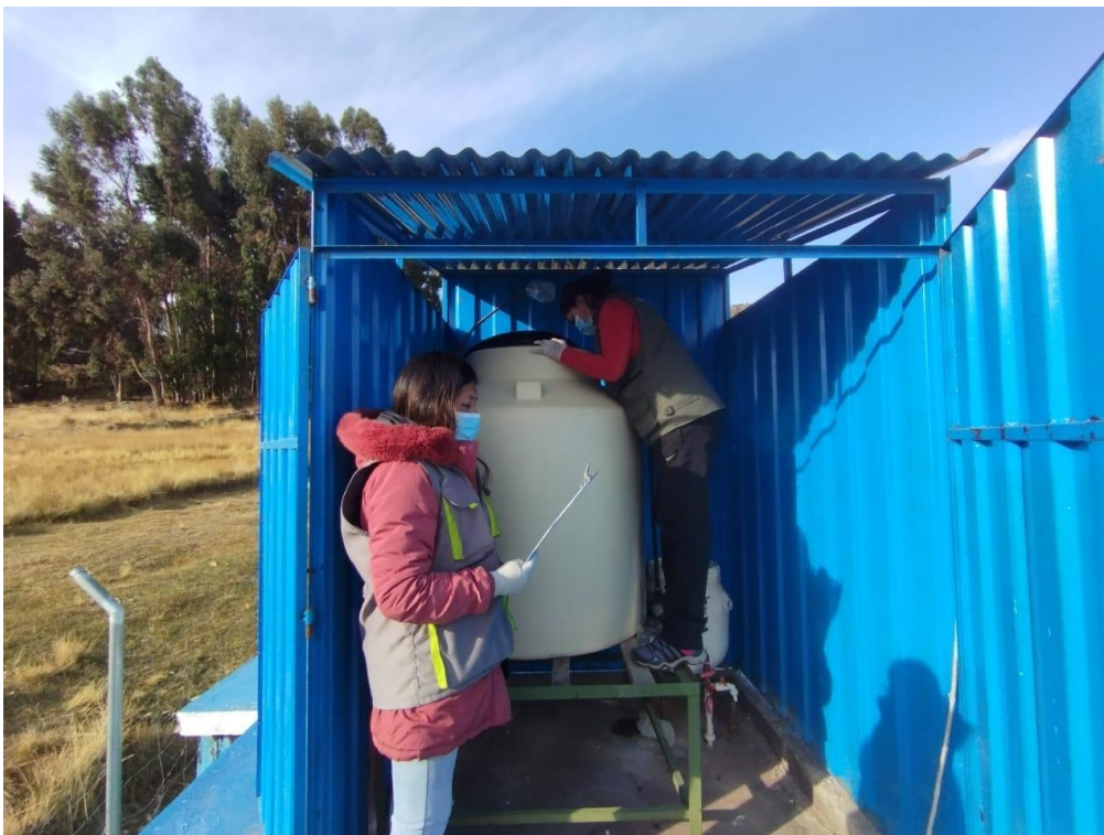
Fotografía 3. Recarga de cloro en el sistema de agua del distrito de Potoni.
