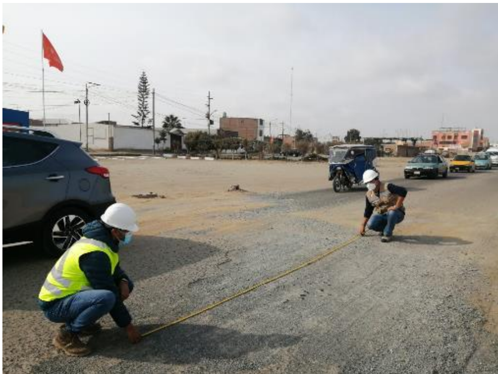
Figura 5 Descascaramiento, pérdida de agregados, desintegración de bordes del pavimento
