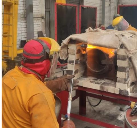
Se inició el cordón de soldadura por la parte interna y se termina a unos 10mm aproximadamente del apéndice (de dentro hacia fuera). El cordón debe tener una altura entre 3 a 4mm y un ancho entre 12 a 15mm. El segundo cordón es paralelo al primer cordón, pero se ubica a 90° con relación a la circunferencia del cuerpo y se repite esta secuencia con los demás cordones, esto para mantener el calor lo más uniforme posible. Además, se controla la temperatura para que no esté por debajo de los 220°C.
