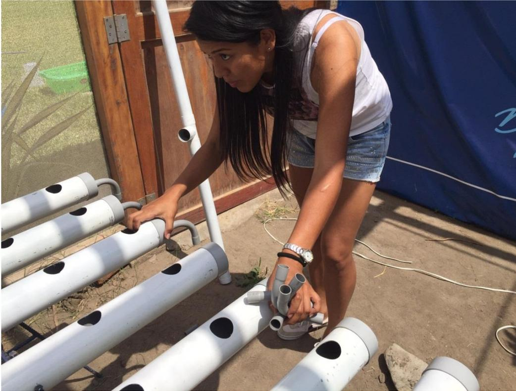
**Figura N° 19:** Instalación de llaves para la recirculación del agua.
