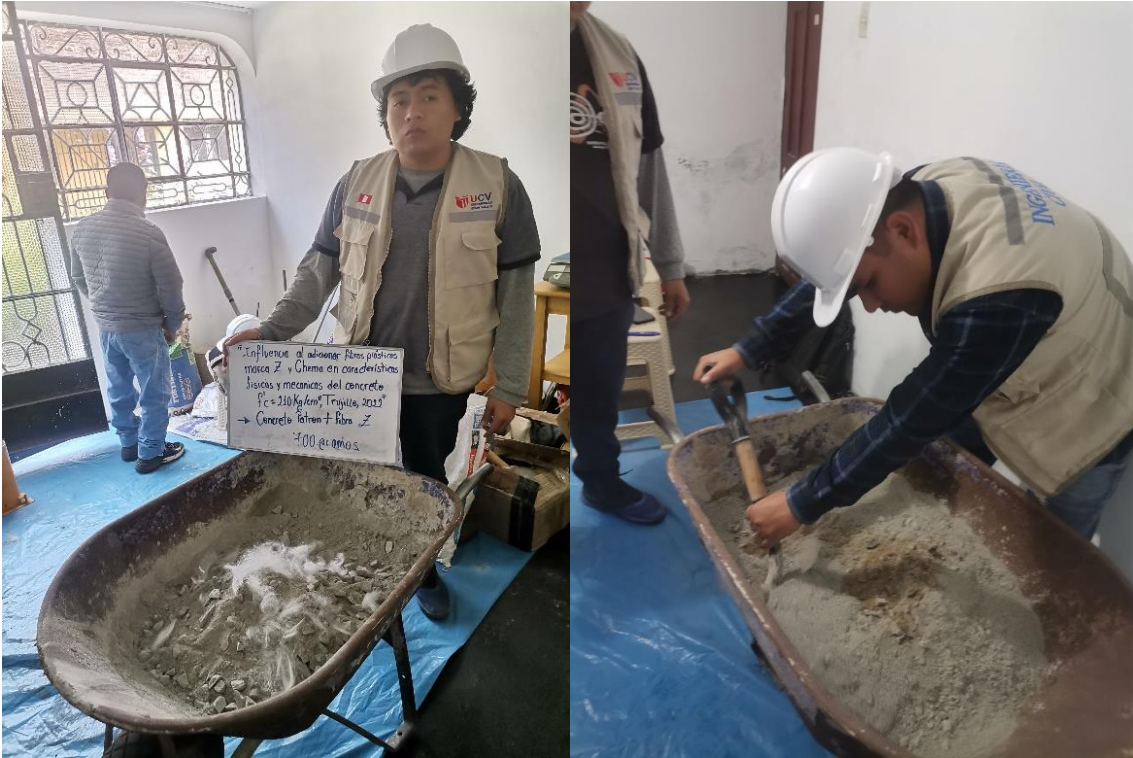
Preparación de las mezclas de concreto en seco.
