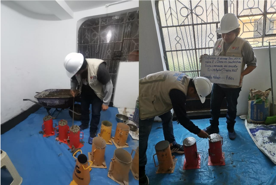
Moldeo de los testigos cilíndricos de concreto.
