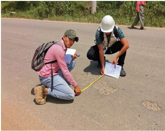
Imagen de desprendimiento de agregado
