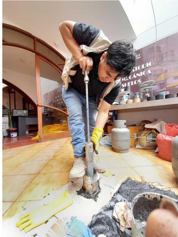
Figura 95. Compactación de la tercera capa.
