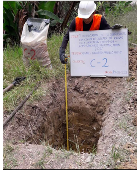
Figura 16 Calicata C-2 (km 11+135).
