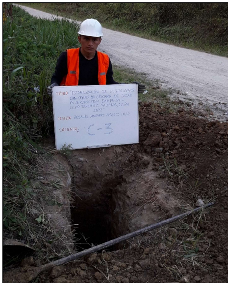
Figura 17 Calicata C-3 (km 11+772).
