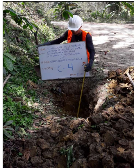
Figura 18 Calicata C-4 (km 12+843).
