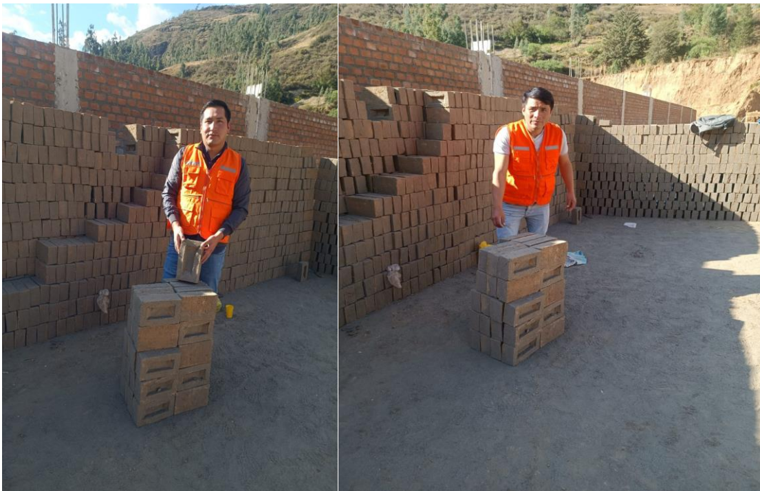
Foto N° 06: Secado de los ladrillos en la cubierta.
