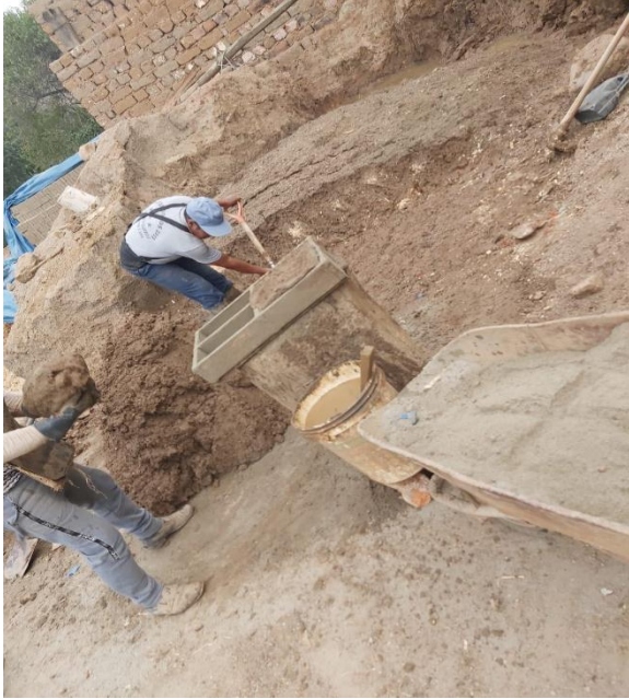
Fotografía 20 y 21: Elaborando los ladrillos artesanales Patrón.
