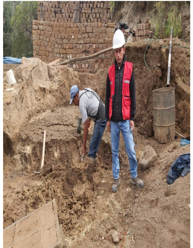
Fotografía 26 y 27: Elaborando el ladrillo artesanal con adición al 15% de Ichu
