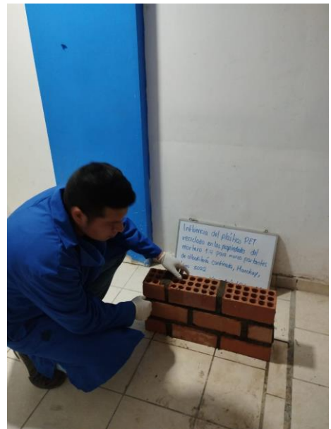
Preparación de murete
