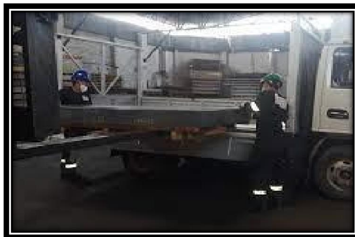
Figura 9. Evidencia de carencia de un montacarga
