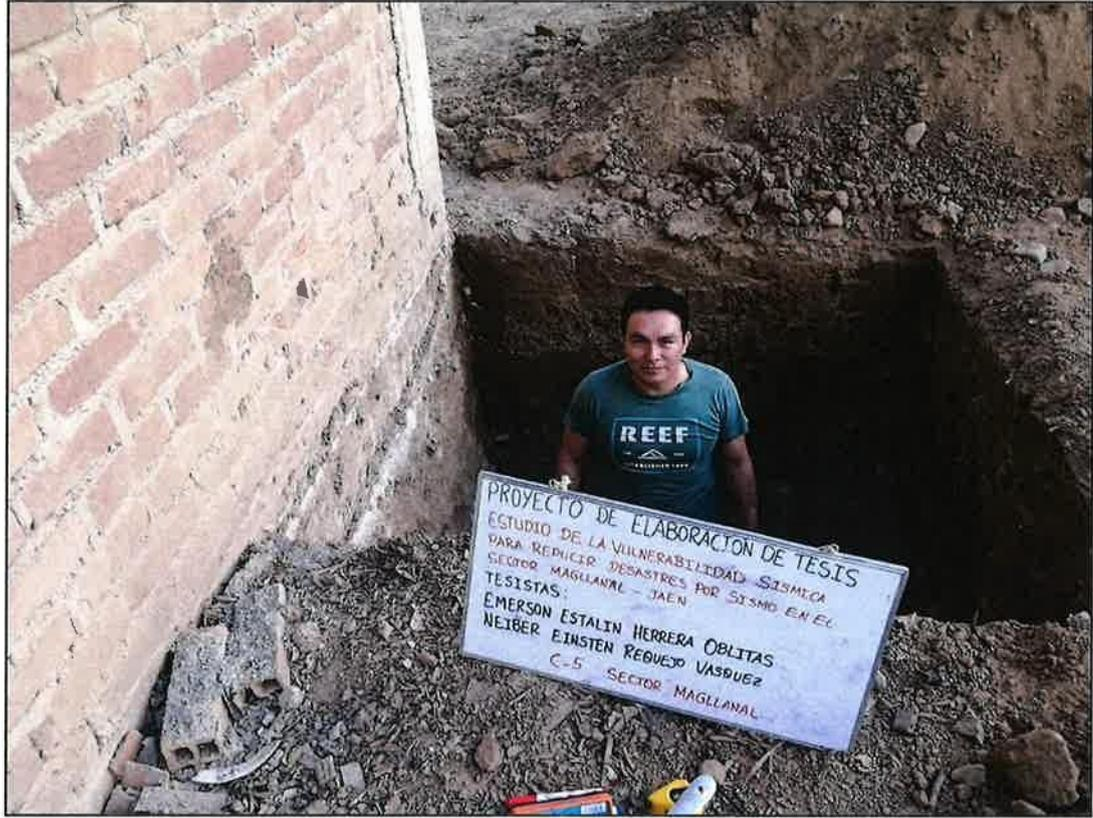
**FOTOGRAFIA 05:** Muestra la Muestra Vista Panorámica de la Excavación De La Calicata C-05, De la Tesis: "ESTUDIO DE LA VULNERABILIDAD SÍSMICA PARÁ REDUCIR DESASTRES POR SISMO EN EL SECTOR MAGLLANAL-JAÉN"
