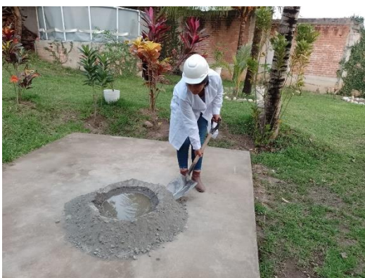
FOTO 15: Preparado del concreto con 0% de fibras de botellas de plástico.
