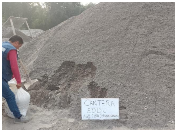
FOTO 02: Recolección de material del agregado fino de la cantera "EDDU".
