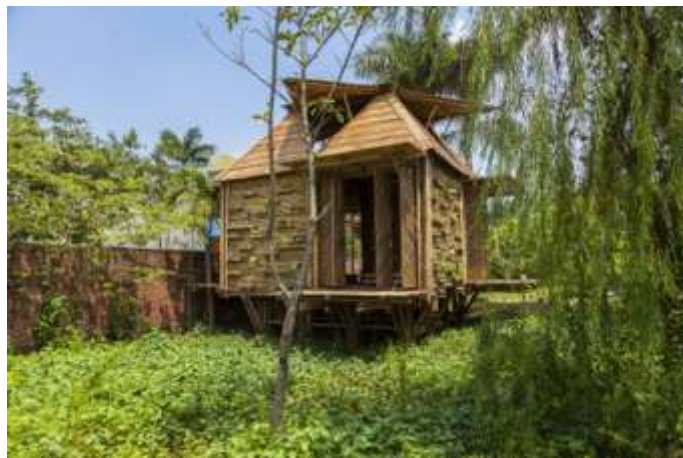
Figura 1: Vivienda construida con bambú
