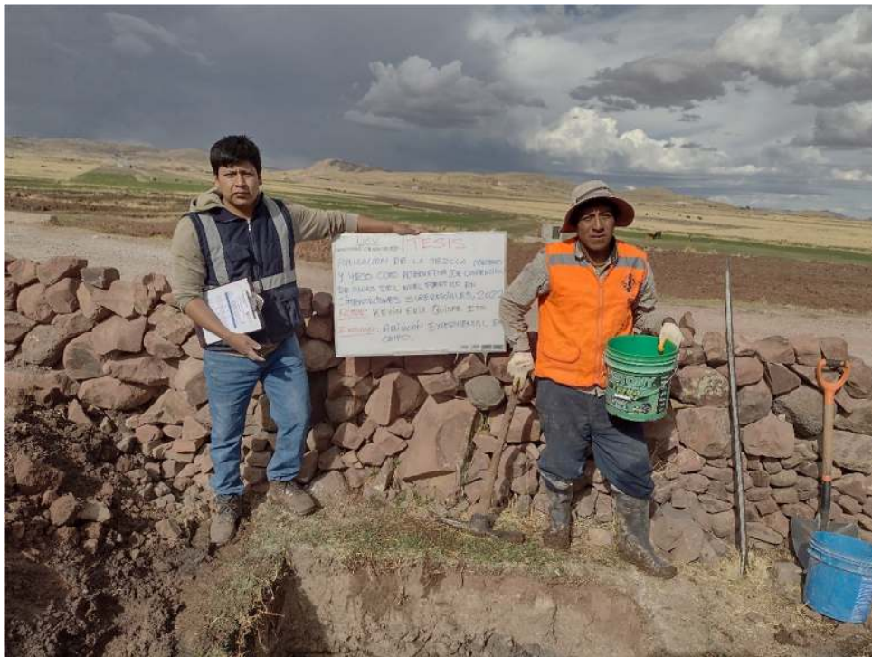
Fotografía 34. Aplicación experimental en campo – excavación.
