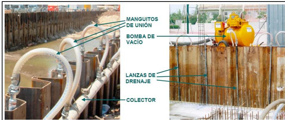
Figura 11. Composición del sistema wellpoints.
