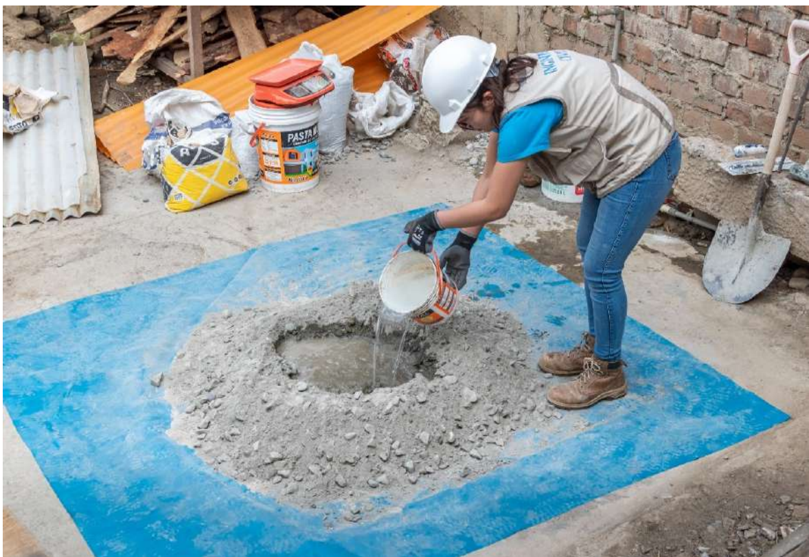
Imagen 10. Adición de agua potable para la elaboración del concreto.
