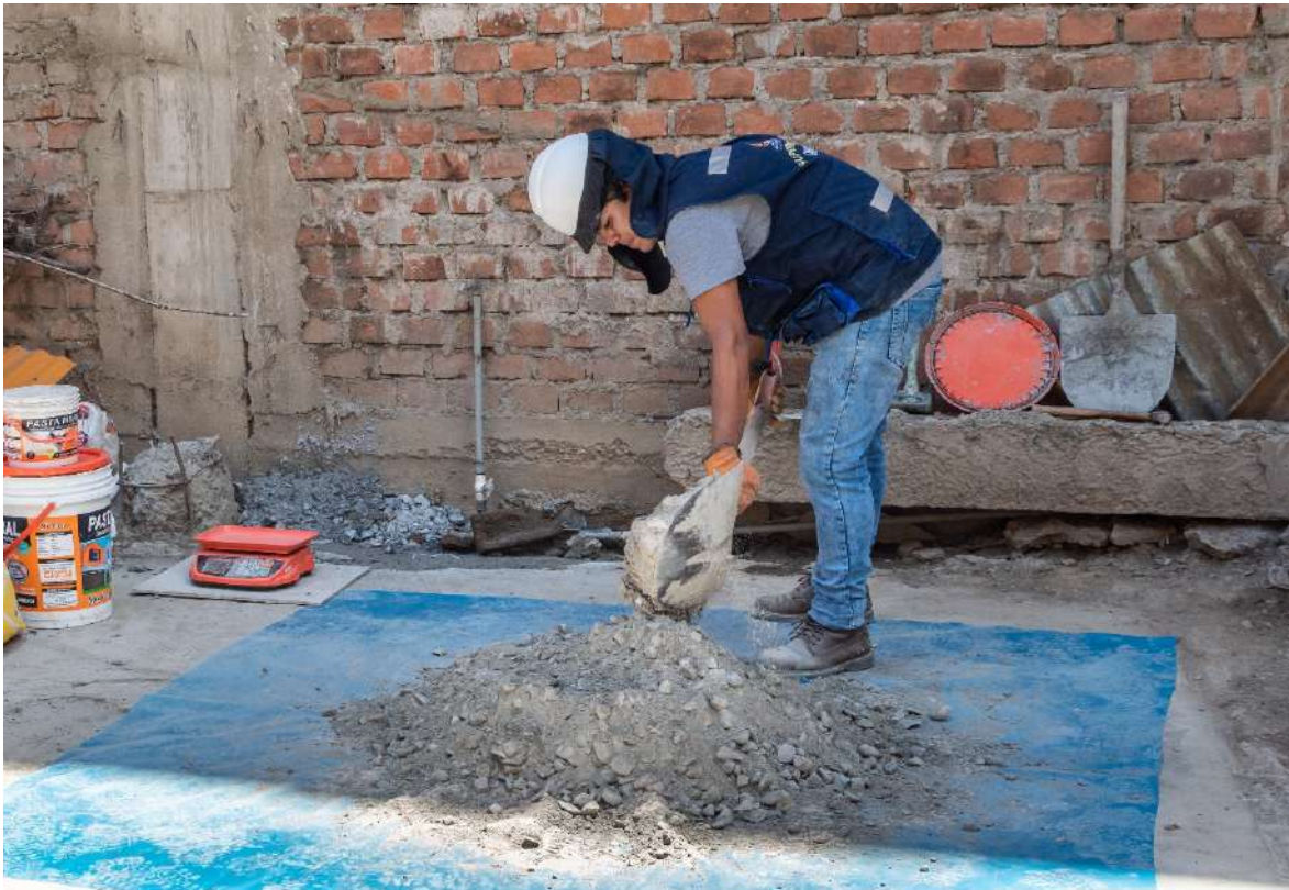
Imagen 9. Mezclado de los materiales entre sí para la elaboración del concreto.
