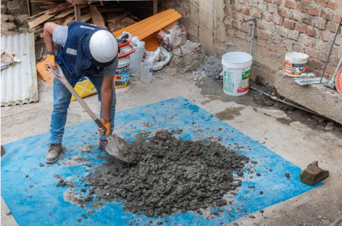
Imagen 11. Batido de la mezcla de concreto.
