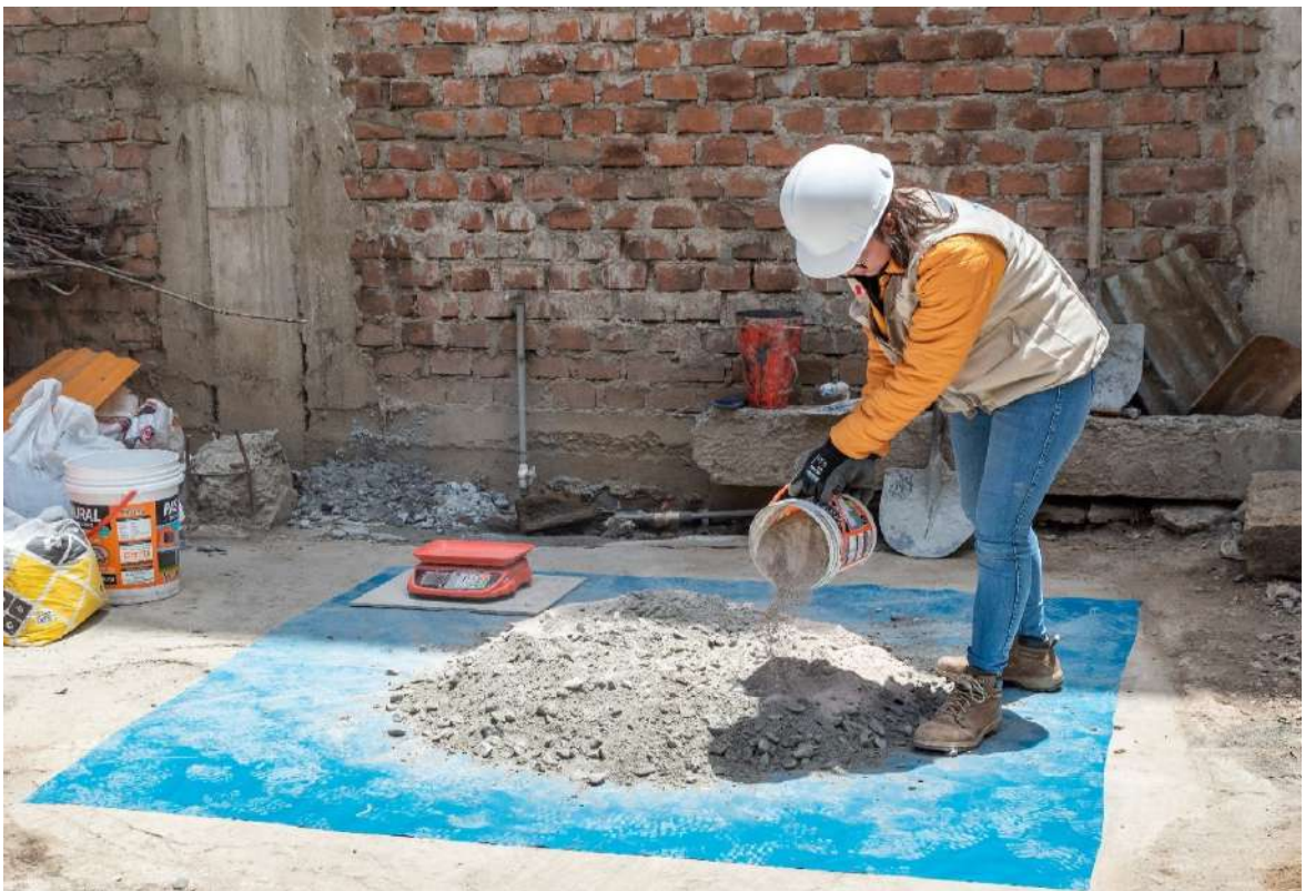
Imagen 8. Preparación de los materiales para la elaboración del concreto.
