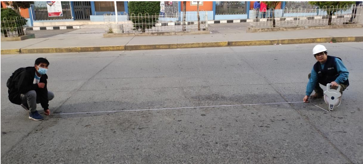
Figura 4. Evaluación de pulimiento con severidad alta (31H).
