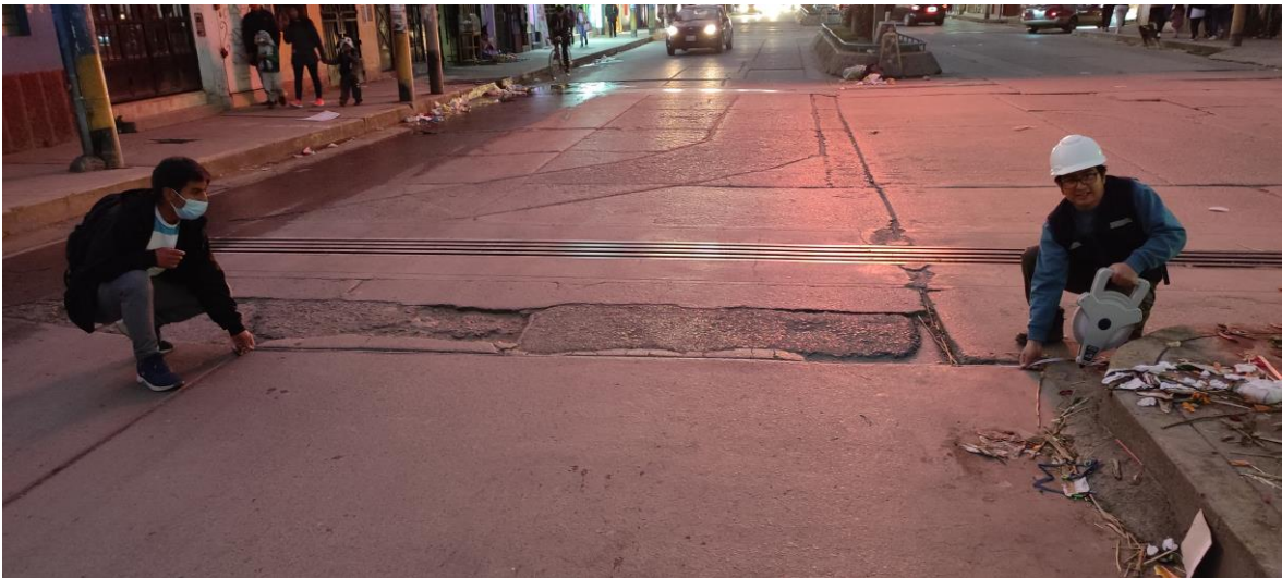
Figura 2. Evaluación de parcheo grande con severidad alta (29H).
