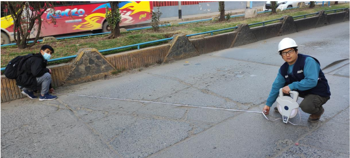
Figura 4. Evaluación de losa dividida con severidad alta (23H).
