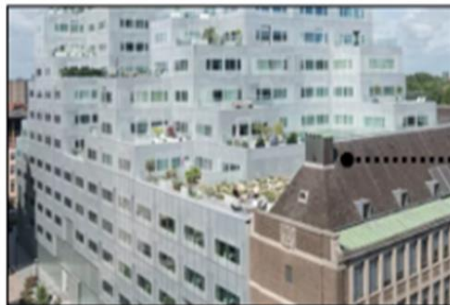
Cubierta Edificio municipal-Vista Oeste
