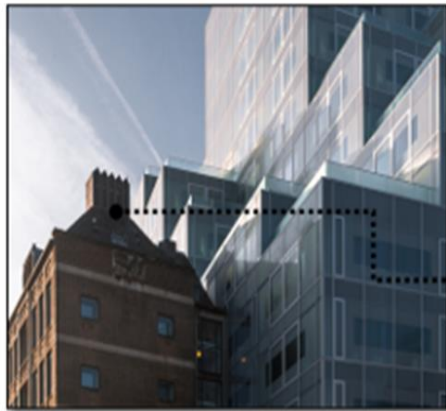
Cubierta Edificio municipal -Vista Norte
