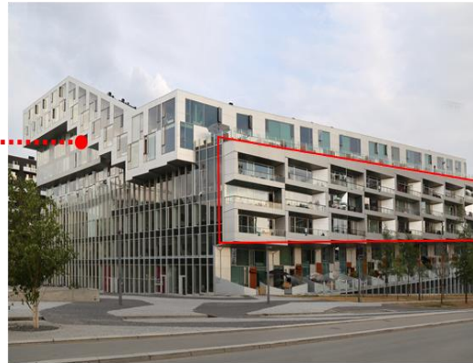
Fachada exterior Norte: formas escalonadas y líneas con movimiento
