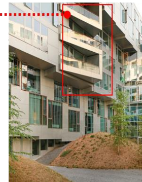
Fachada interior, patio 1: volúmenes sobresalientes
