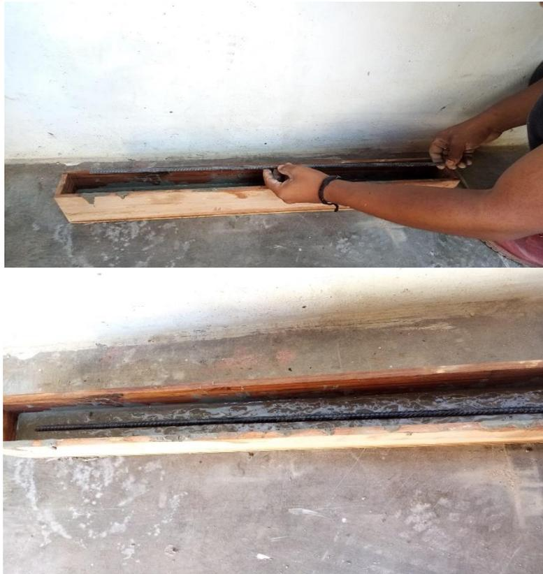
**Figura 42.** *Colocado de acero de refuerzo*
