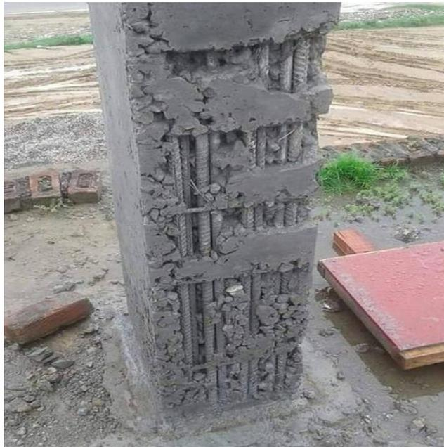
**Figura 4.** Segregación del concreto. Tomada de “Propiedades físicas y mecánicas del hormigón”, por (Izquierdo, Izquierdo, & Ramalho, 2018)
