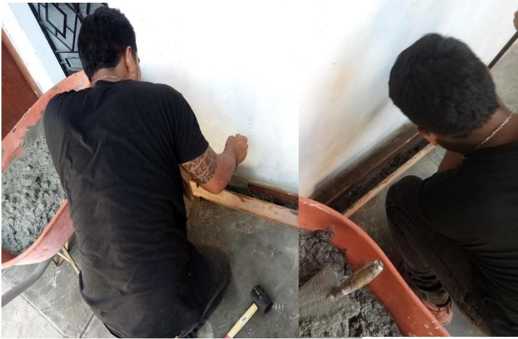
**Figura 39.** *Llenado de primera capa de concreto*
