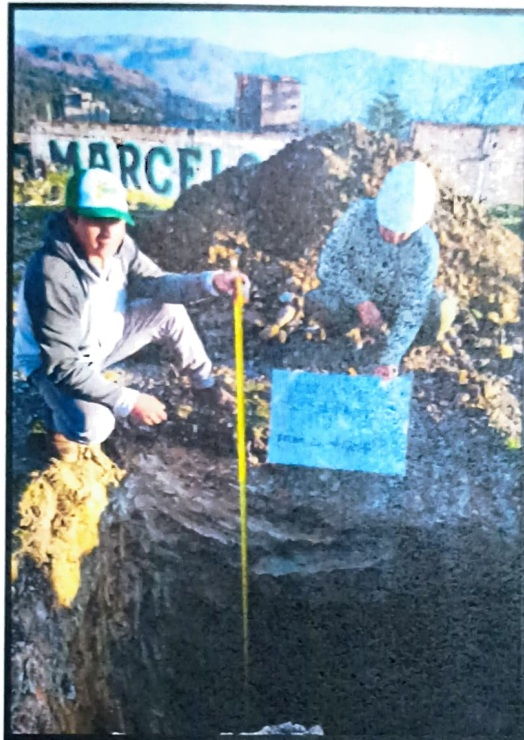
Fotografía 5. Se observa la calicata N° 03 realizada en la Calle S/N 01
