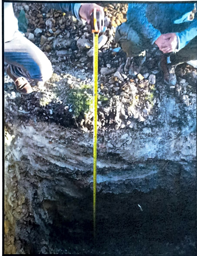
Fotografía 15. Se observa la toma de medidas de la calicata N° 09 en la Calle S/N 04
