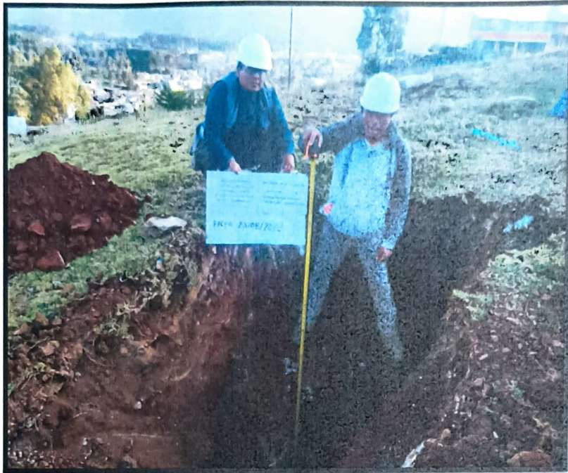
Fotografía 9. Se observa la calicata N° 05 realizada en Jr. Esmeralda
