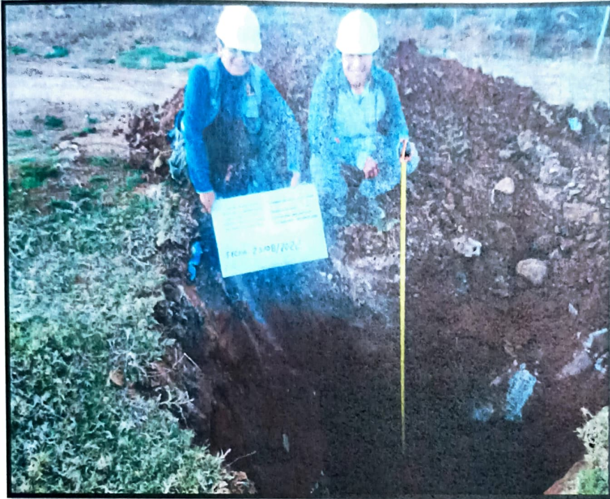
Fotografía 7. Se observa la calicata N° 04 realizada en el Psje La Amistad
