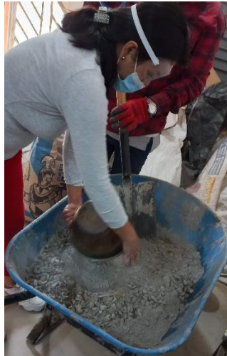
Figura 7. Preparación de mezcla de concreto.
