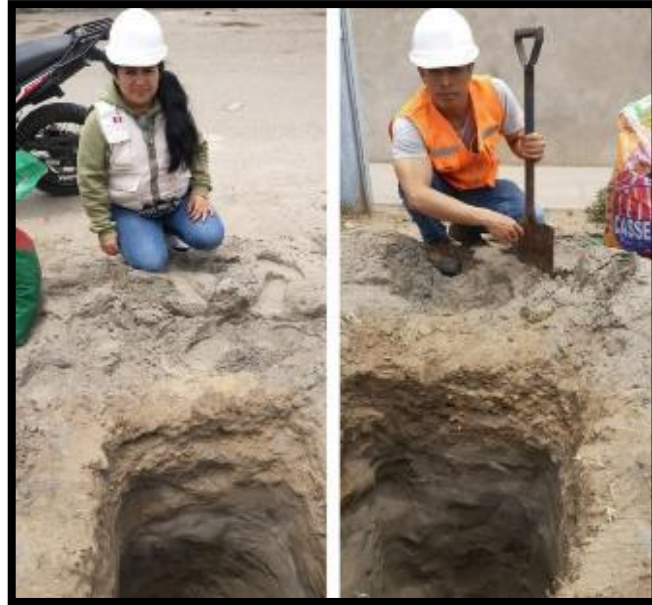
Figura 03. Excavación de calicatas
