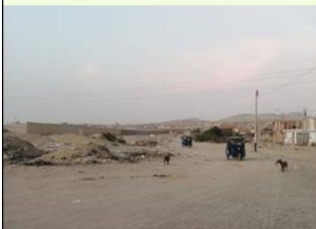
Vista del muro frente al sector.
