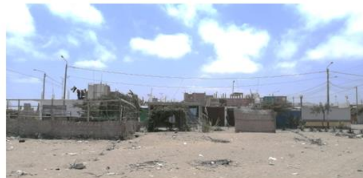
Vista 1. Los elementos naturales en malas condiciones no permiten visualizar la cuadra en su totalidad, perjudicando el paisaje en ese sector.
