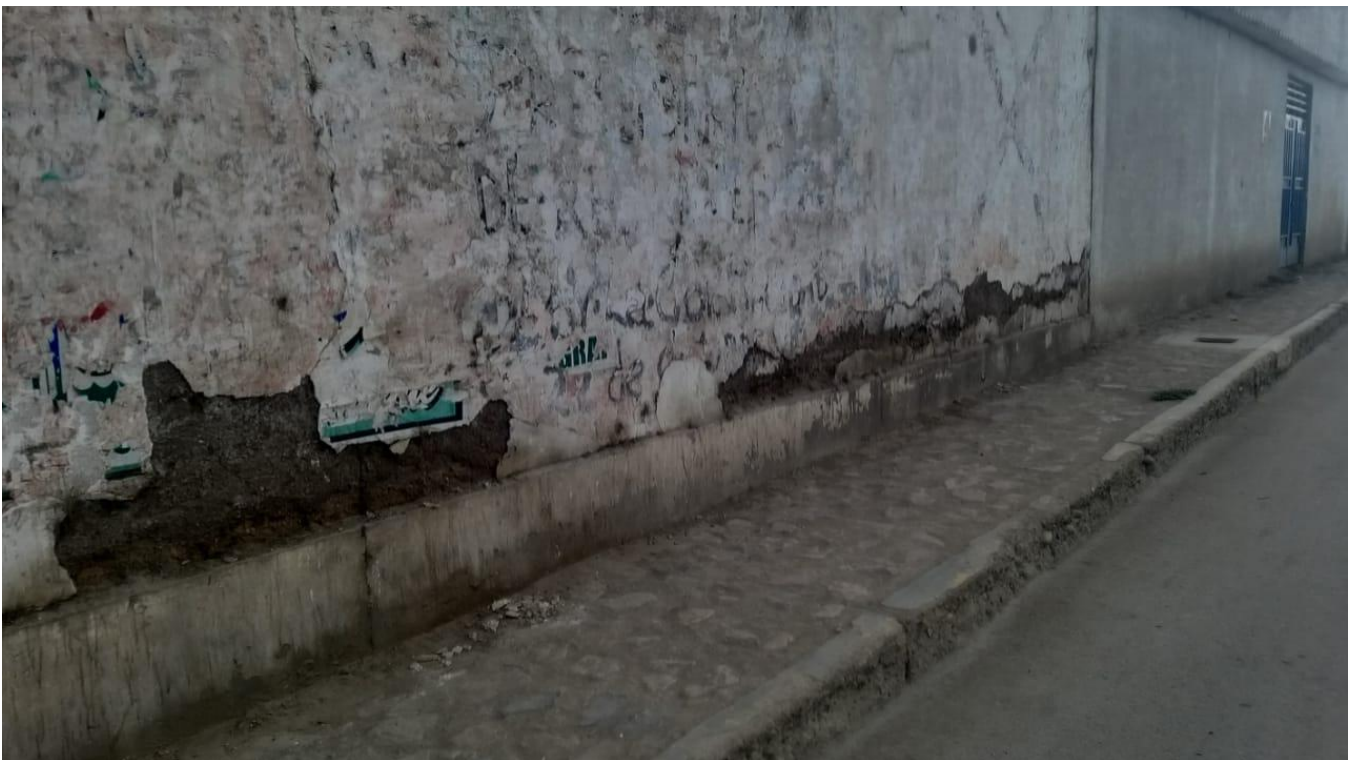
Figura 106: Vías de acceso al camal de Ferreñafe
