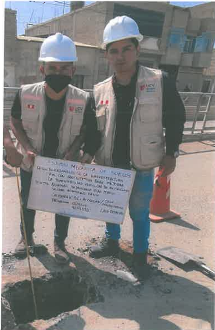
FOTOGRAFÍA 06: Muestra la ubicación de la calicata C – 06 del proyecto: “Reforzamiento de la Infraestructura Vial con Geomalla para Mejorar la Transitabilidad Vehicular de la Av. Chiclayo, José Leonardo Ortiz”
