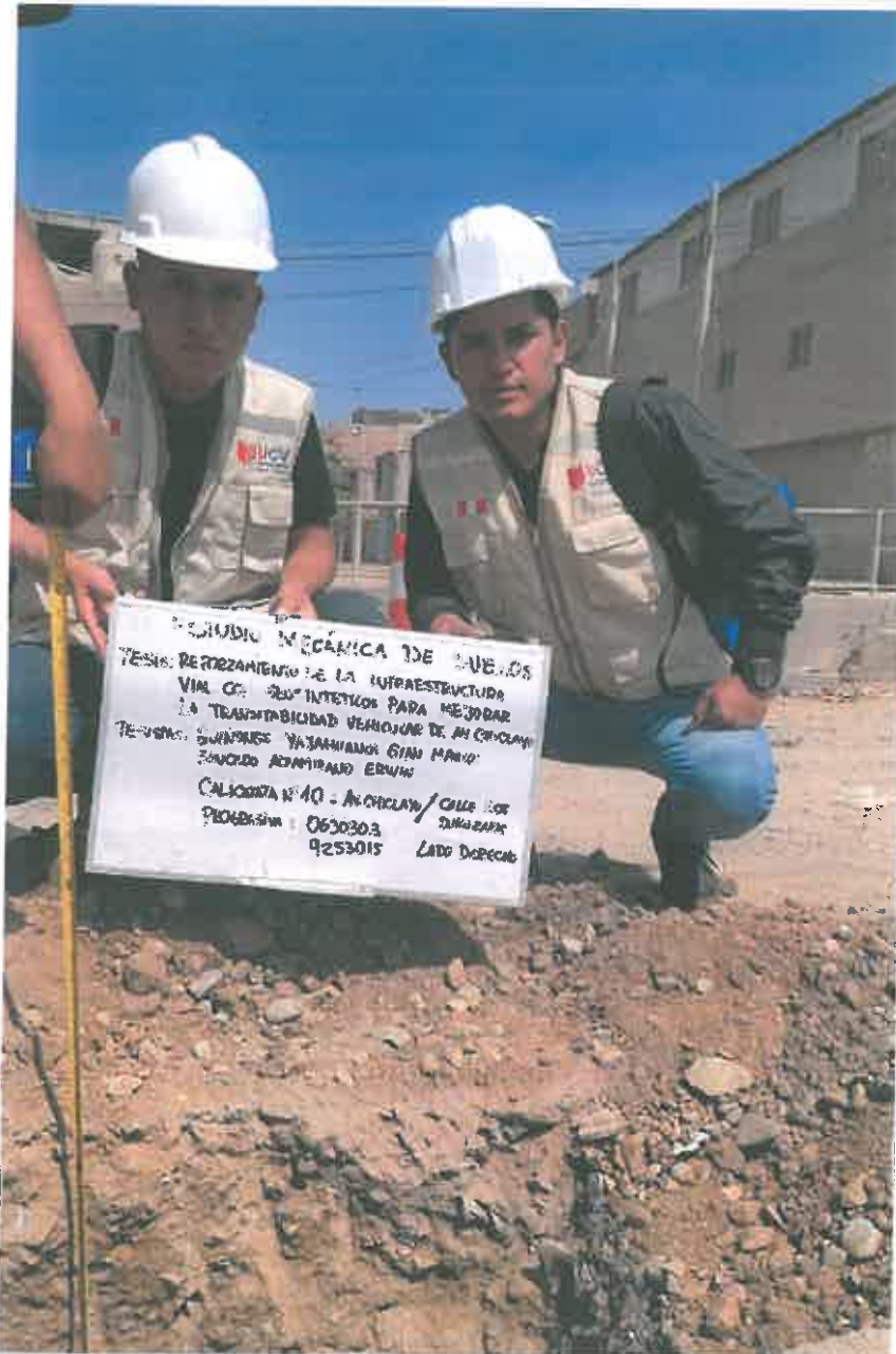
FOTOGRAFÍA 10: Muestra la ubicación de la calicata C – 10 del proyecto: "Reforzamiento de la Infraestructura Vial con Geomalla para Mejorar la Transitabilidad Vehicular de la Av. Chiclayo, José Leonardo Ortiz"
