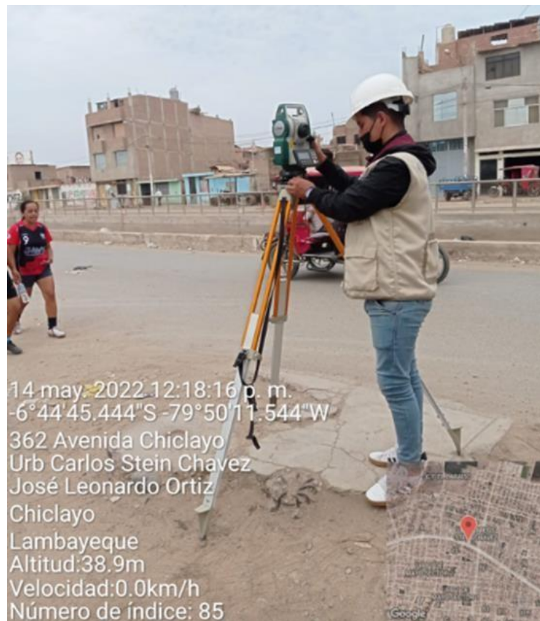
Figura 4 Colocación y nivelación de la estación total.
