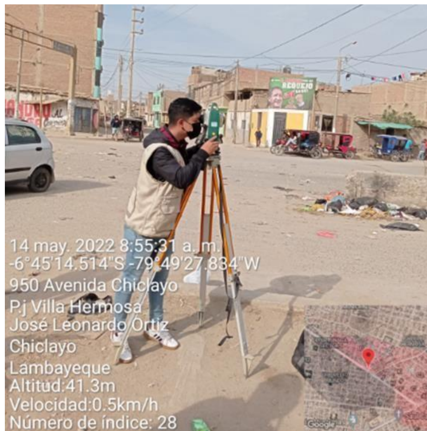
Figura 2 Levantamiento topográfico con estación total.
