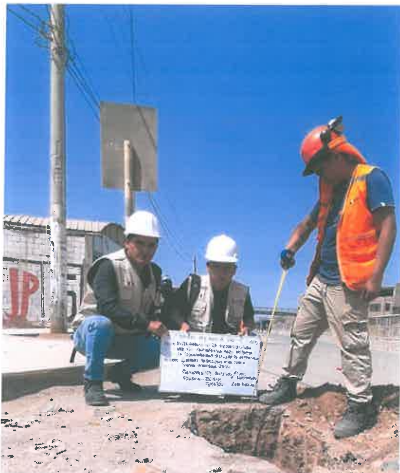
FOTOGRAFÍA 09: Muestra la ubicación de la calicata C – 09 del proyecto: "Reforzamiento de la Infraestructura Vial con Geomalla para Mejorar la Transitabilidad Vehicular de la Av. Chiclayo, José Leonardo Ortiz"
