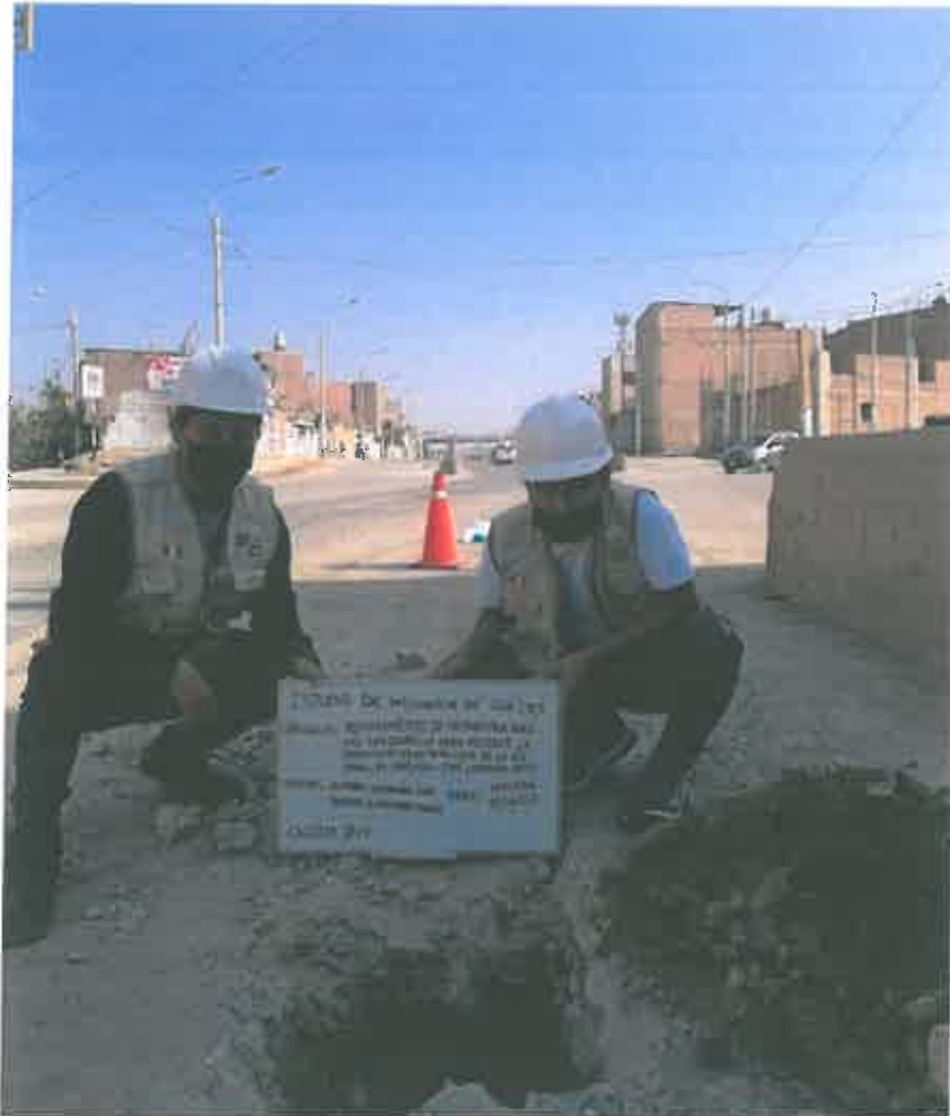
FOTOGRAFÍA 07: Muestra la ubicación de la calicata C – 07 del proyecto: “Reforzamiento de la Infraestructura Vial con Geomalla para Mejorar la Transitabilidad Vehicular de la Av. Chiclayo, José Leonardo Ortiz”
