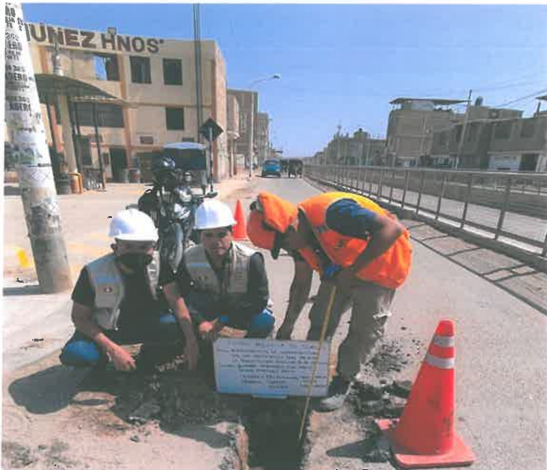
FOTOGRAFÍA 05: Muestra la ubicación de la calicata C – 05 del proyecto: “Reforzamiento de la Infraestructura Vial con Geomalla para Mejorar la Transitabilidad Vehicular de la Av. Chiclayo, José Leonardo Ortiz”
