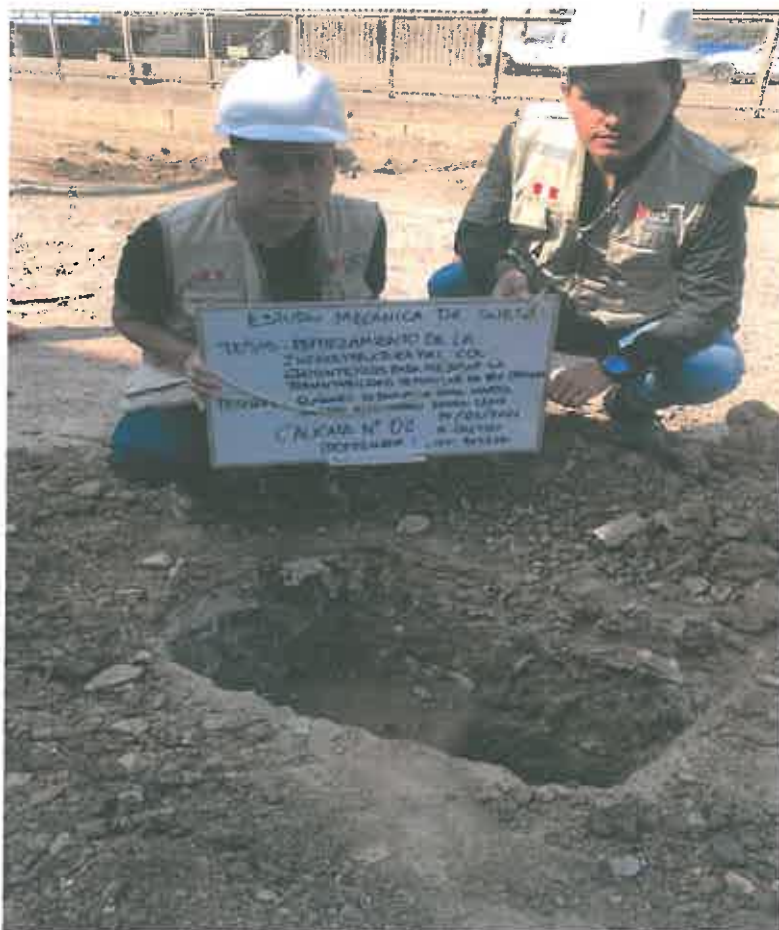
FOTOGRAFÍA 01: Muestra la ubicación de la calicata C – 02 del proyecto: "Reforzamiento de la Infraestructura Vial con Geomalla para Mejorar la Transitabilidad Vehicular de la Av. Chiclayo, José Leonardo Ortiz"
