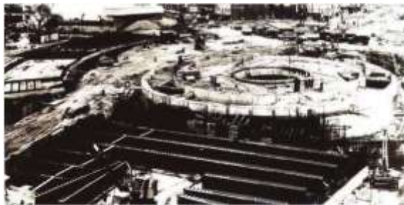
Figura 3: Construcción de la Glorieta del Metro Insurgentes. 1969.
