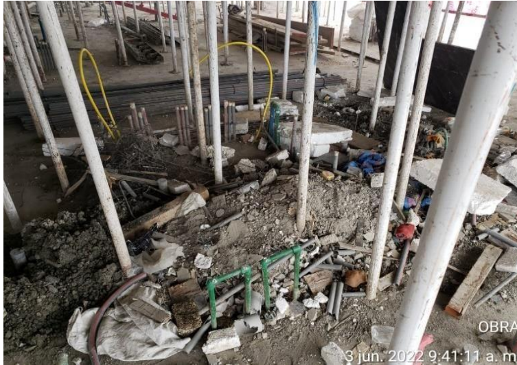
Figura 1. Centro de acopio de materiales construcción Proyecto Liberi (Tuberías de PVC) Fuente: Elaboración Propia
