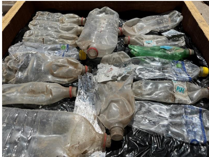
Figura 5. Implementación de capa impermeable y botellas PET.
