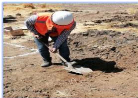
Ilustración 5 EXCAVACION DE CALICATA
