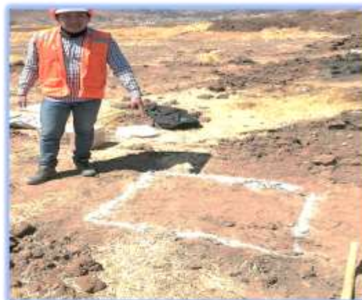
Ilustración 3 DEMARCACION DE CALICATA
