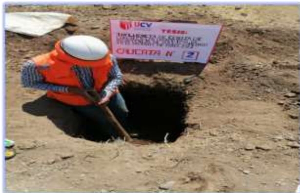
Ilustración 12 EXCAVACION DE CALICATA 2
