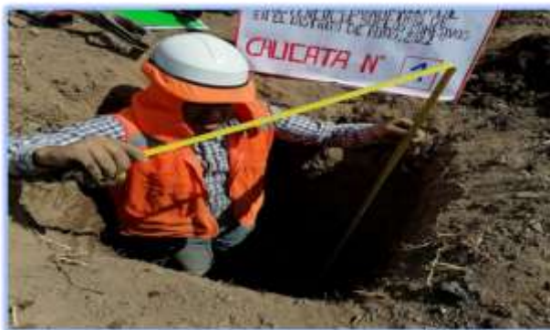
Ilustración 11 PROFUNDIDAD DE CALICATA
