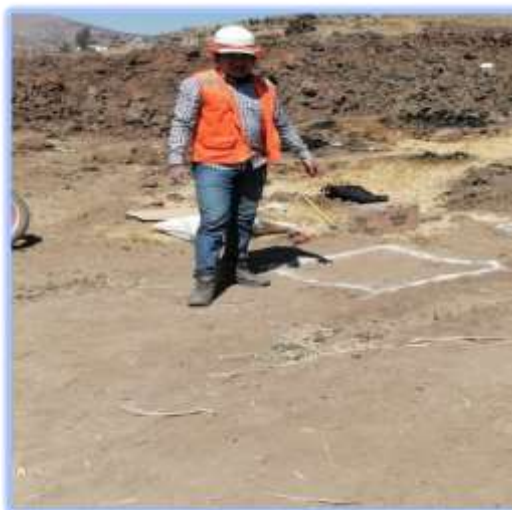
Ilustración 4 DEMARCACION DE CALICATA
