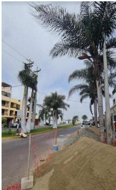
Foto N 02.- Vía principal - Av. el Golf Tramo 9
