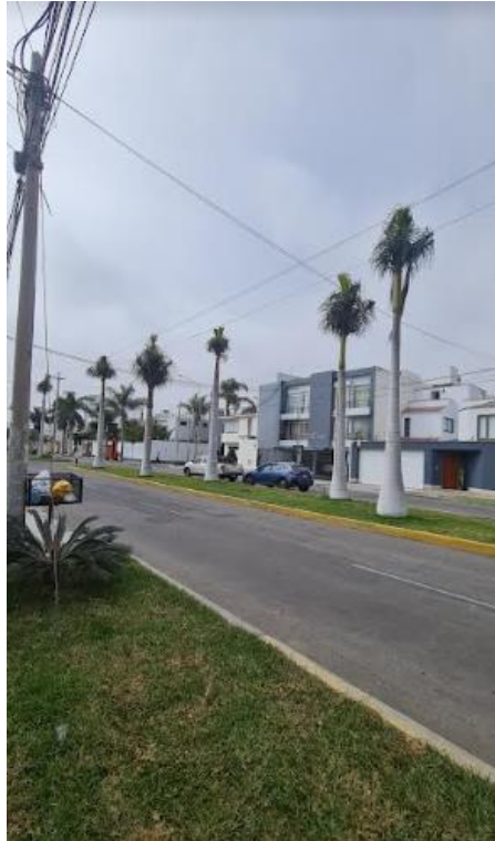
Foto N 01.- Vía principal - Av. el Golf Tramo 7
