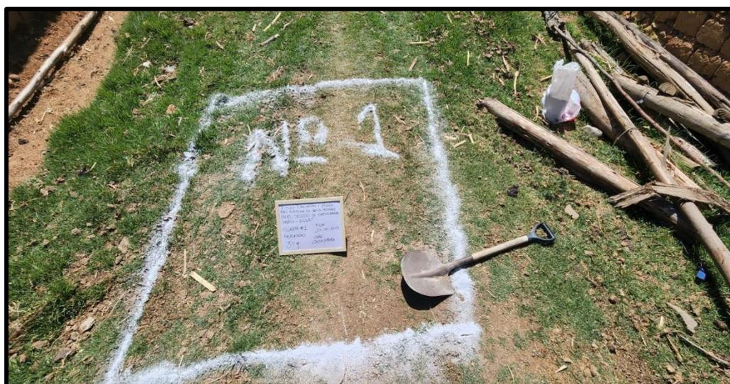
**Figura N° 4: Trazo para la excavación de la calicata n° 1 en el caserío de Cacchupampa.**
