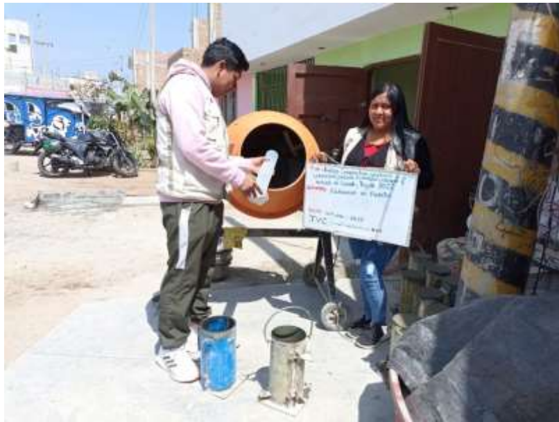
Figura 21. Mezcla de concreto.
